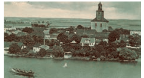
Auf Tafel 6: Blick auf das Ostufer mit dem Schorn- stein der 1. Stromfabrik
